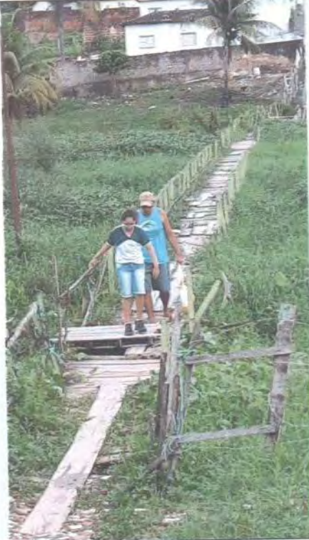
Foto 01: Detalhe da situação atual no local da futura construção da Passagem Molhada
