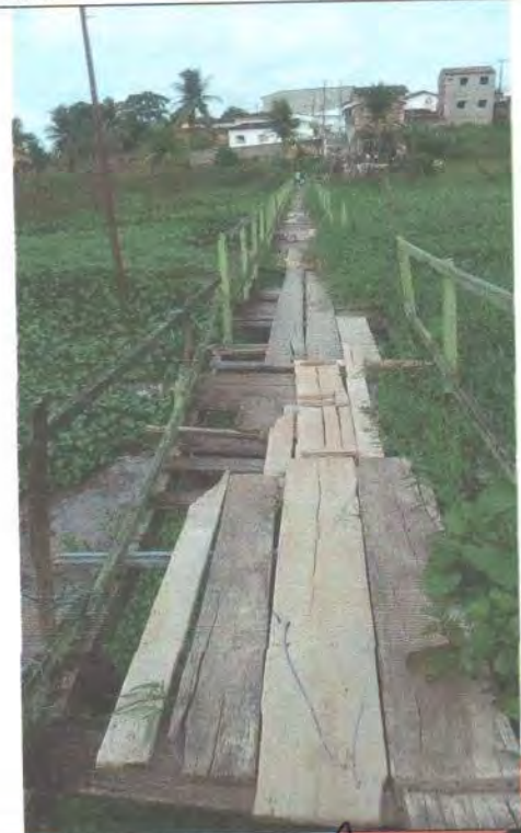
Foto 04: Vista do material construtivo na via de pedestre da comunidade local
