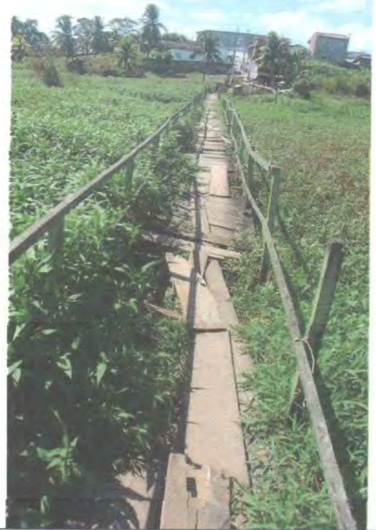
Foto 06: Vista Panorâmica da situação atual da futura construção da Passagem Molhada
